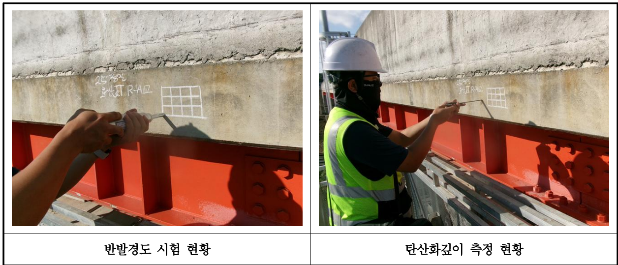
【사진 29.4.1】 콘크리트 내구성조사 현황
