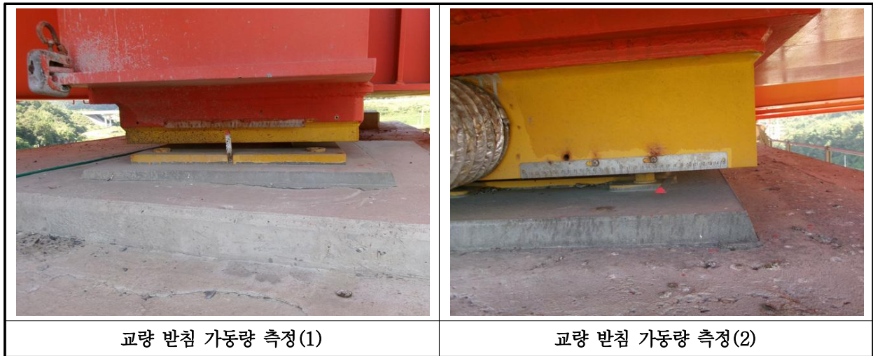
【사진 29.3.16】 교량받침 이동량 측정
