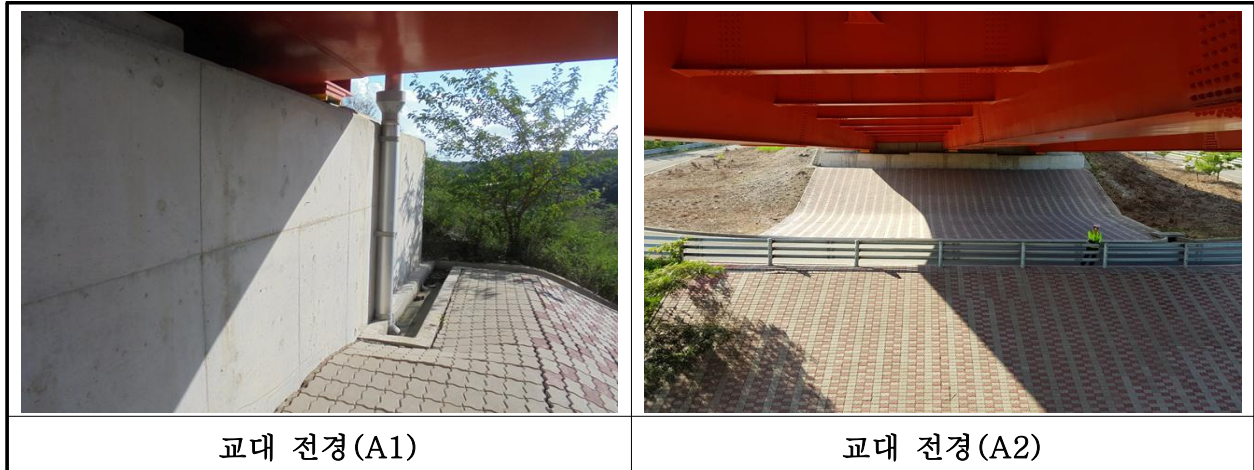
【사진 29.3.8】 교대 전경
