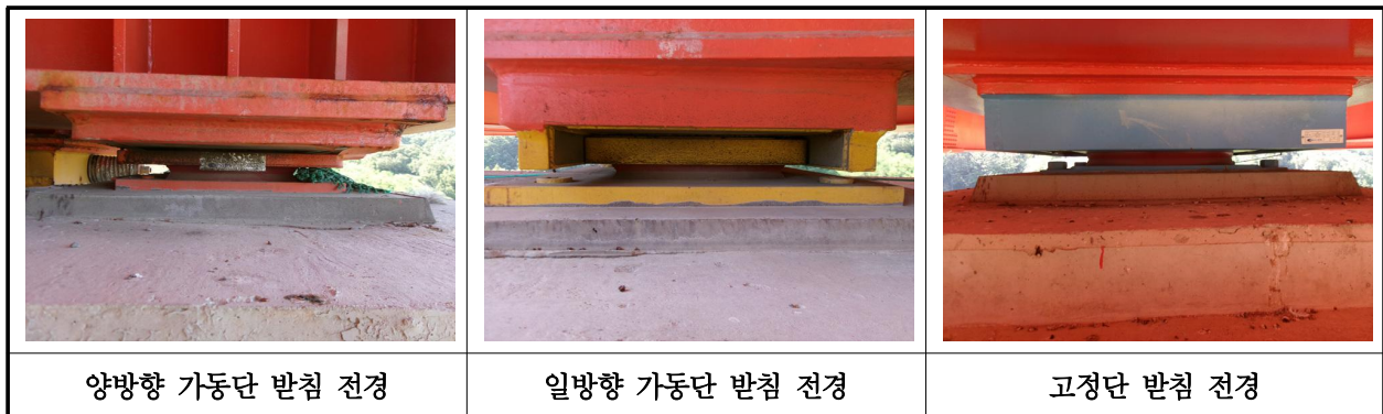
【사진 29.3.13】 교량받침 전경
