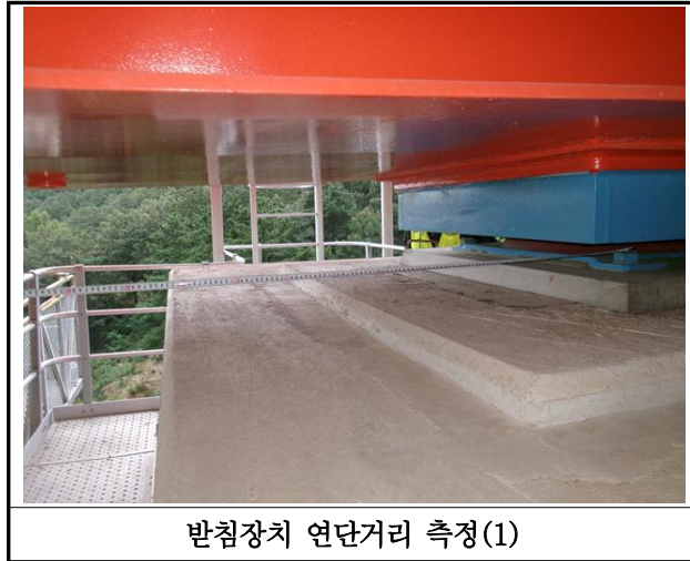
【사진 29.3.15】교량받침장치 연단거리측정
