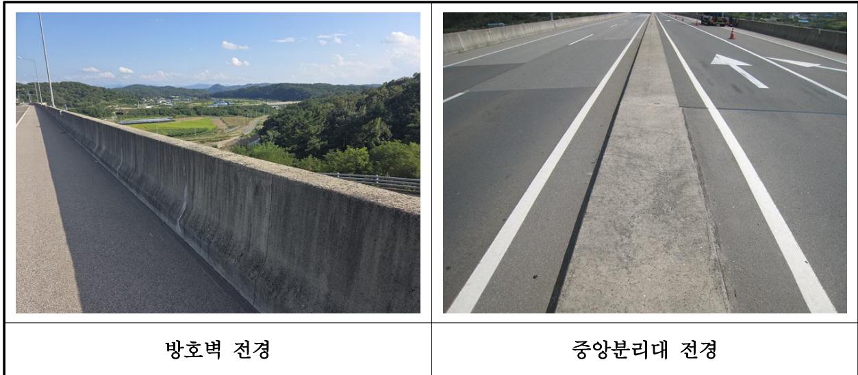
【사진 29.3.24】 방호벽 및 중앙분리대 전경
