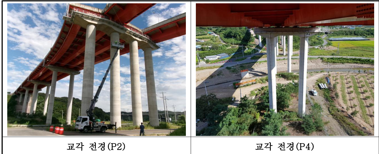
【사진 29.3.10】 교각 전경
