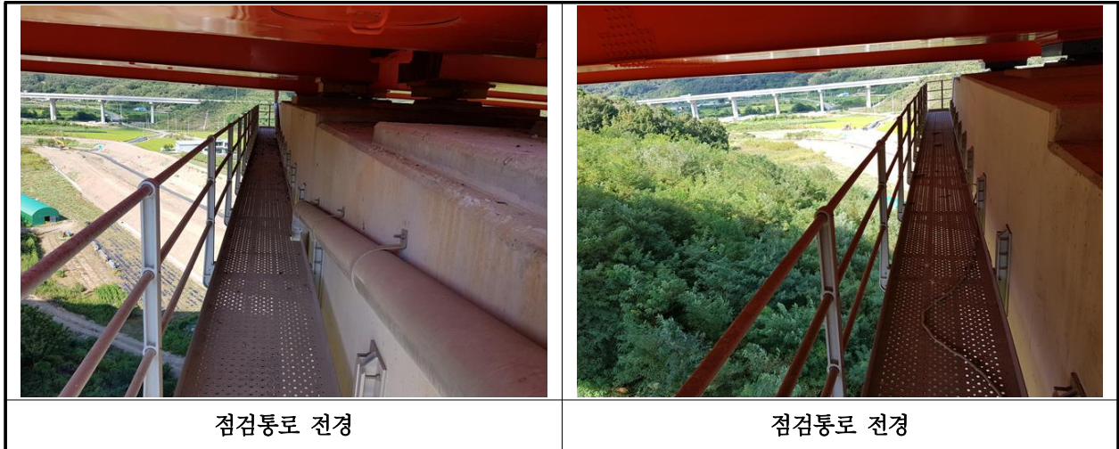
【사진 29.3.26】 교량 점검시설 전경
