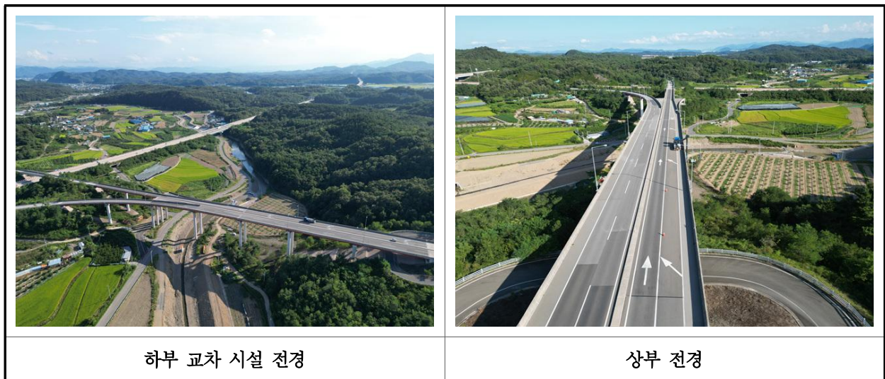
【사진 29.2.1】 부재 현장측정 전경
