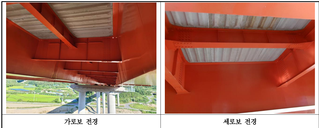
【사진 29.3.6】 가로보 및 세로보 전경
