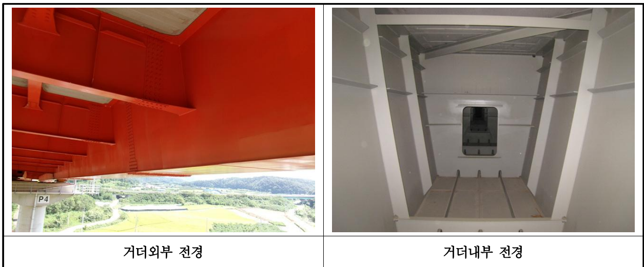
【사진 29.3.4】 거더 전경
