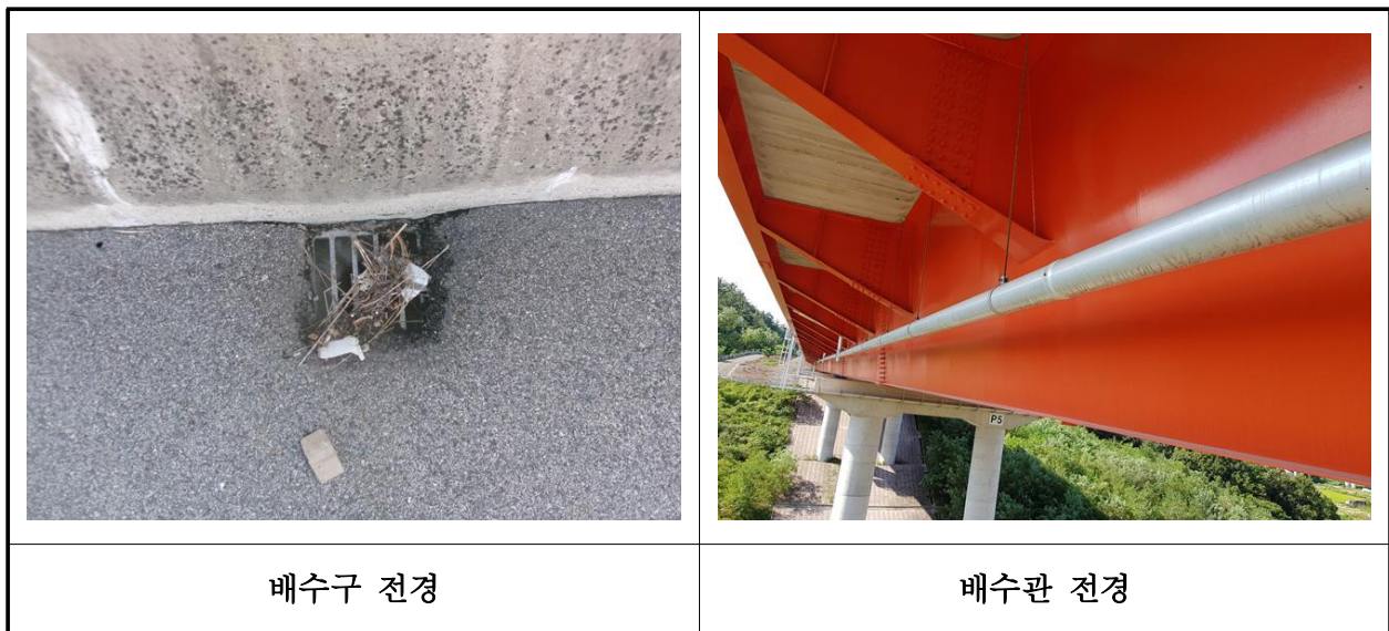
【사진 29.3.22】 배수시설 전경
